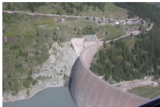
Vista da monte della diga. Si osserva il lago alla quota di 1700 m s.l.m.
