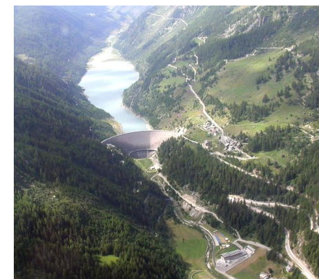
Vista della diga di Beauregard da valle
