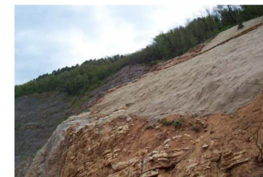
Rivestimento di una parte del pendio riprofilato con georete in fibra di juta
