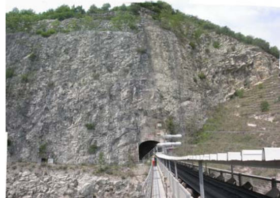
Attuale imboccatura della galleria TN1 col nastro trasportatore per lo stock pile
