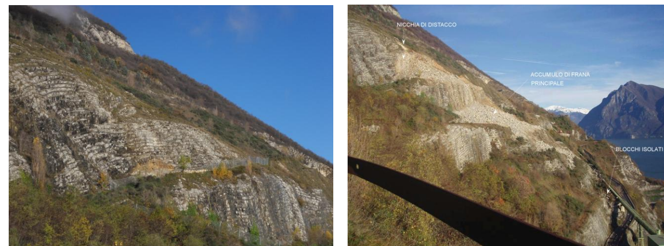
Figura 3. Panoramica del versante prima dell'evento (sx); versante franato (dx).
